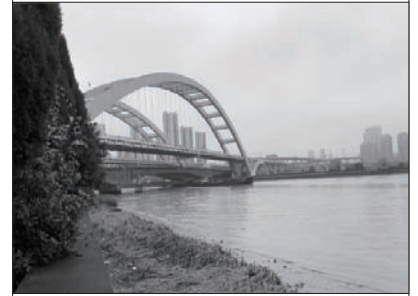
köprü ve tünellerin deformasyonunu izleme
